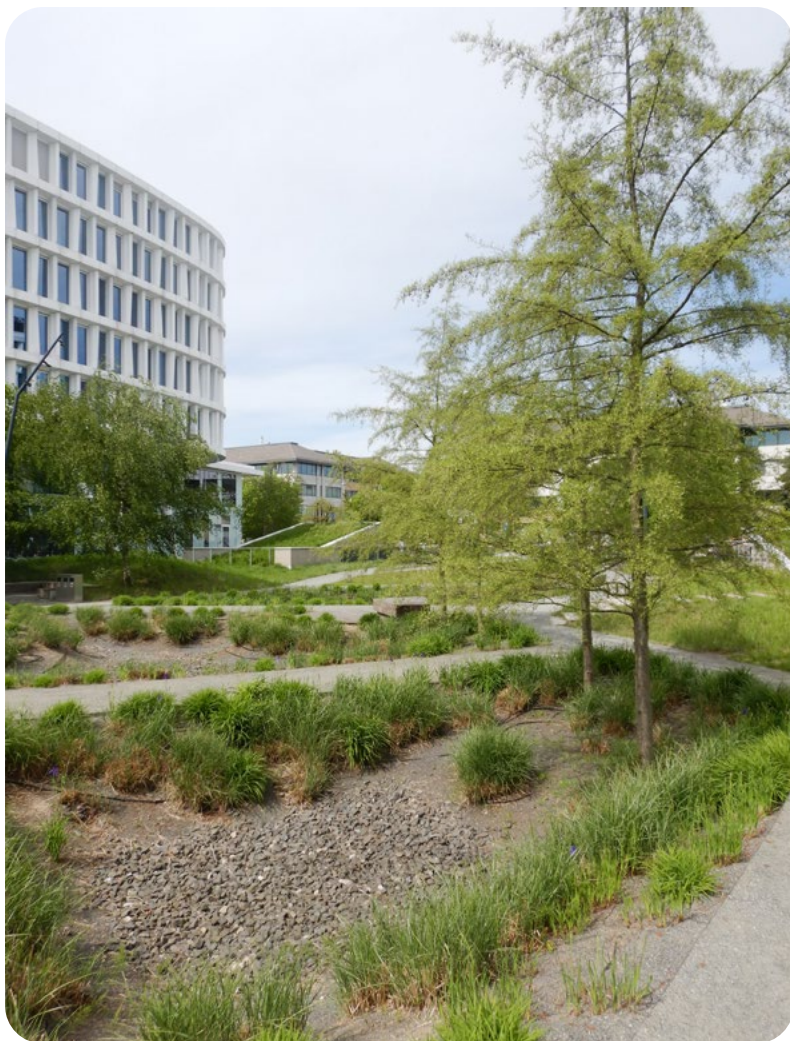
Ryc. 17. Bioretencja otwarta na stropodachach, przy kompleksie biurowców (Źródło: Biuro Ochrony Środowiska, UM Warszawa)
