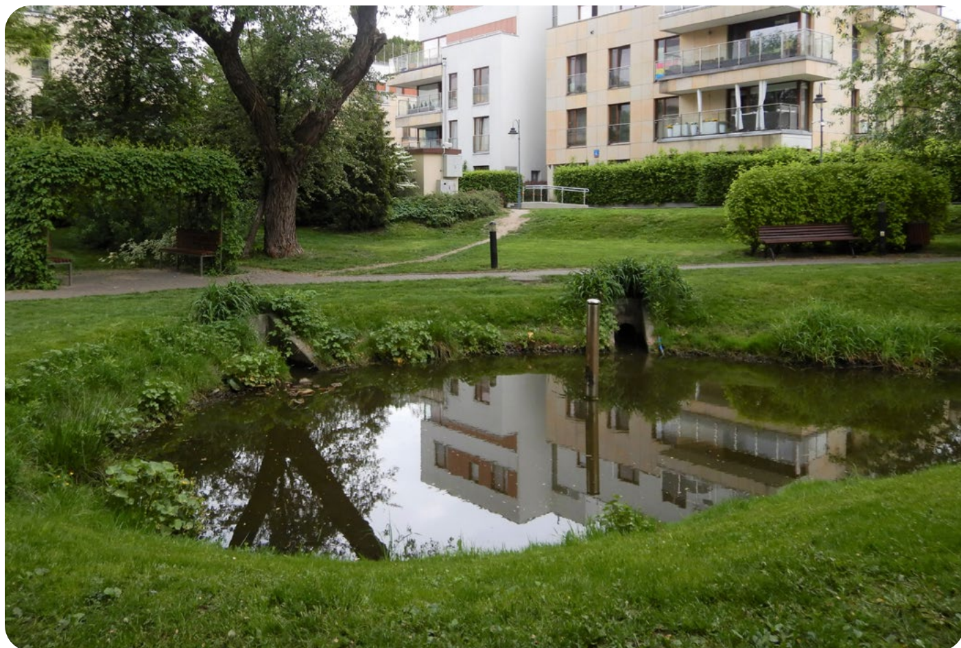
Ryc. 13. Otwarty zbiornik retencyjny na terenie osiedla mieszkaniowego (z odprowadzeniem wód opadowych z dachów)
