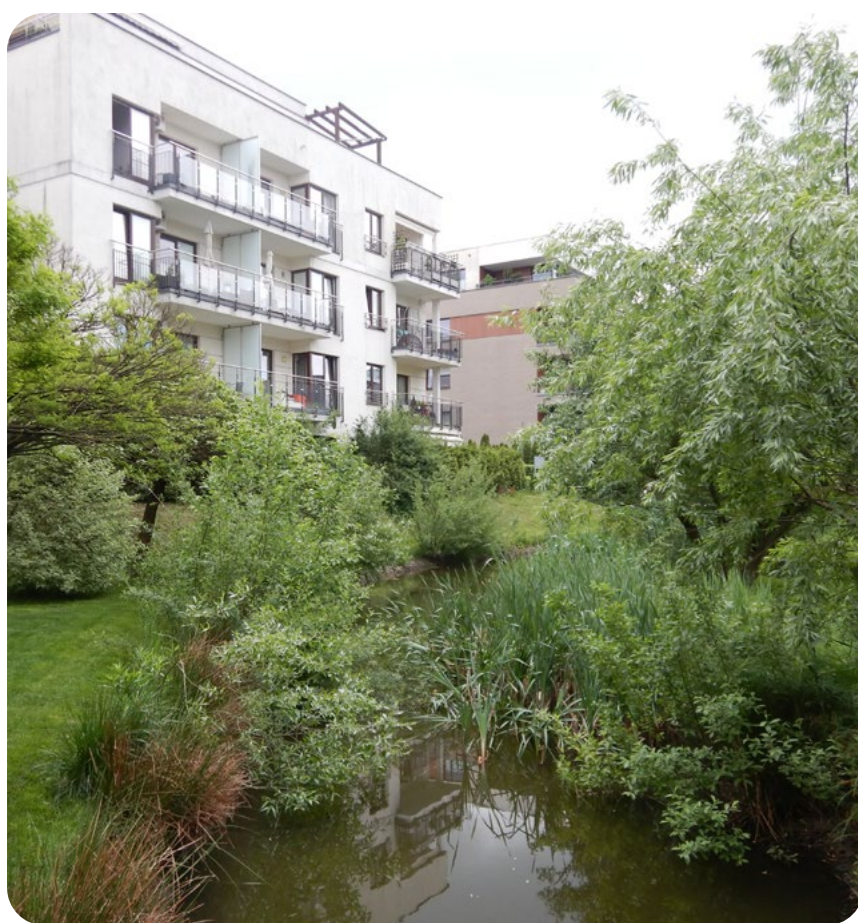
Ryc. 20. Zagospodarowanie brzegów cieków na osiedlu mieszkaniowym
