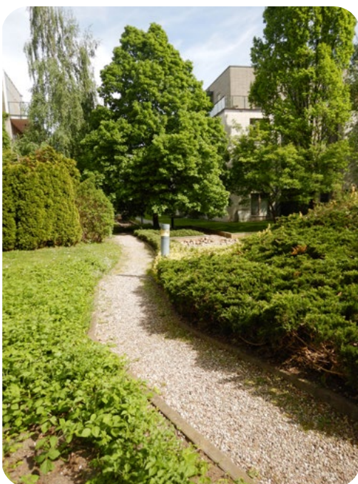
Ryc. 12. Nawierzchnie przepuszczalne dla wody (również na drodze przeciwpożarowej)
