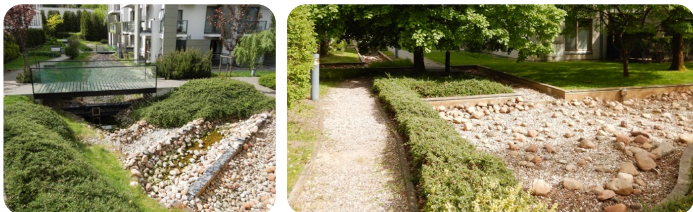
Ryc. 14. Ogrody z funkcją retencji na terenie zabudowy mieszkaniowej
