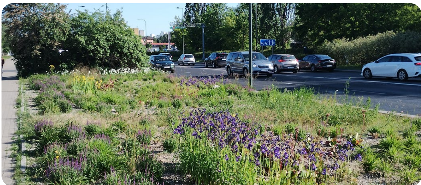
Ryc. 16. Bioretencja otwarta na terenach przyulicznych (Źródło: Biuro Ochrony Środowiska, UM Warszawa)
