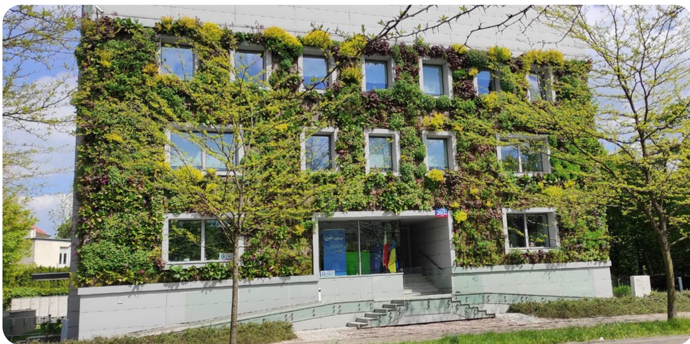
Ryc. 29. Zielone fasady (pnącza, krzewy, byliny, trawy) zastosowane na całej elewacji budynku
