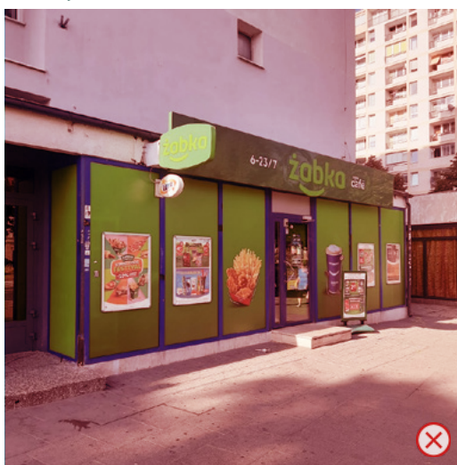
11. Witryny sklepowe wyklejone folią odchodzą do przeszłości – Al. Solidarności 68.
