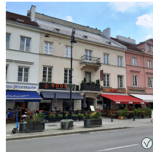
3. Markizy zamontowane za stałe do elewacji zaciniają ogródki wzdłuż Nowego Światu.
