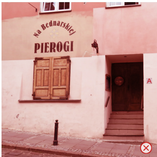
1. Elewacja w czterech kolorach – Bednarska 30.
