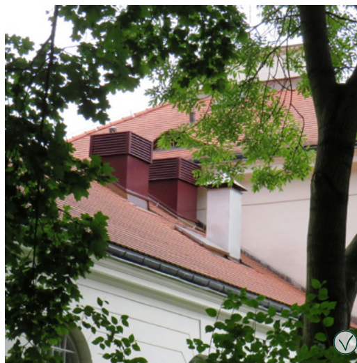
2. Wyrzutnie powietrza jak kominy na dachu – Łazienki Królewskie.
