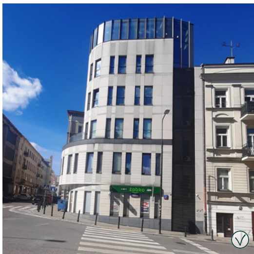
1. Instalacje schowane za ażurową ścianką- Kopernika 21.
