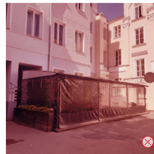
6. Foliowy namiot na tyłach Nowego Świata należy rozebrać lub zastąpić trwałą konstrukcją.
